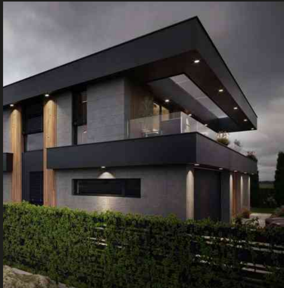
Přední terasa s průhledem skylight
